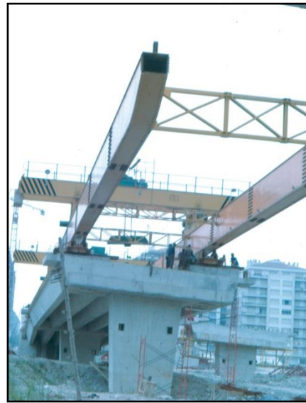
Avance del puente por fases constructivas (8).
